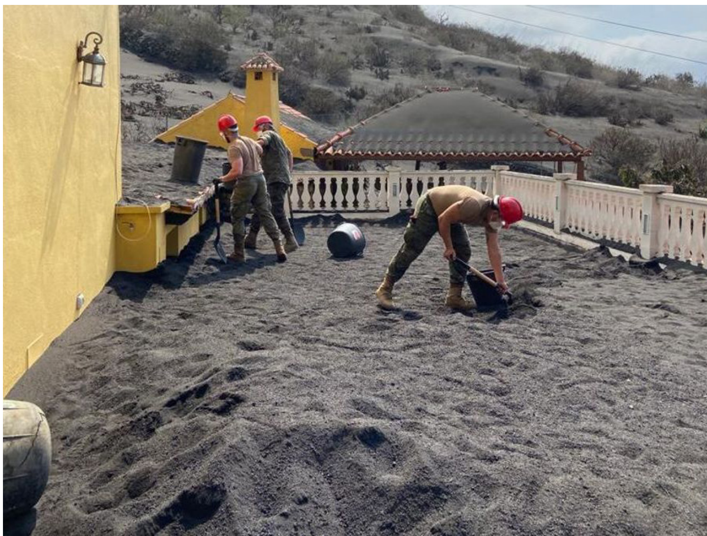
Imágenes de los trabajos para despejar la ceniza del volcán de La Palma. UME
